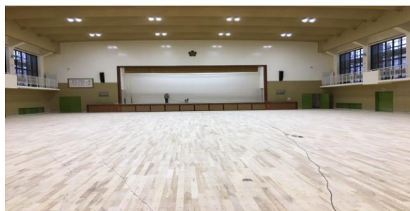
体育館の大規模改修工事の進捗
