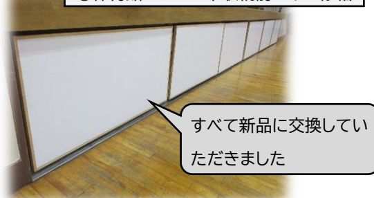
①体育館ステージ下収納前パネル修繕
